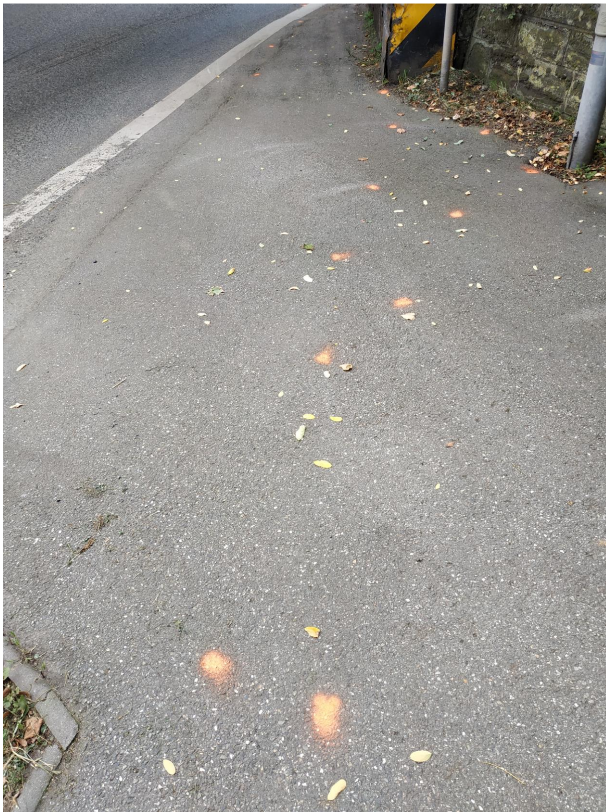
Obr.1 – 2: most v km 53,910 – vytýčené trasy kabel sítí CETIN.
